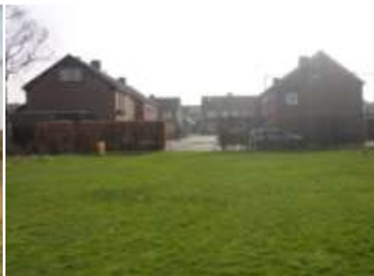
Aanzicht van de onderzoekslocatie in zuidelijke richting met de achtergelegen woningen aan de A.M. de Jongstraat.
