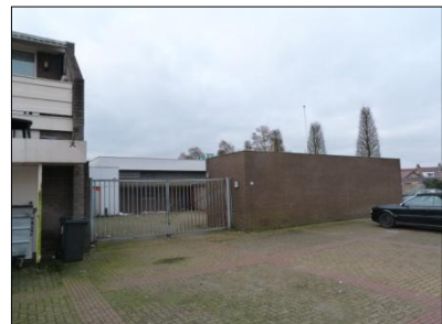
Figuur 8. Achterzijde bedrijfspanden.
