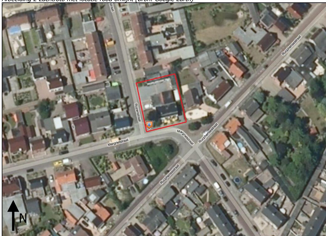
Afbeelding 2 Luchtfoto met locatie rood omlijnt (Bron: Google Earth)
