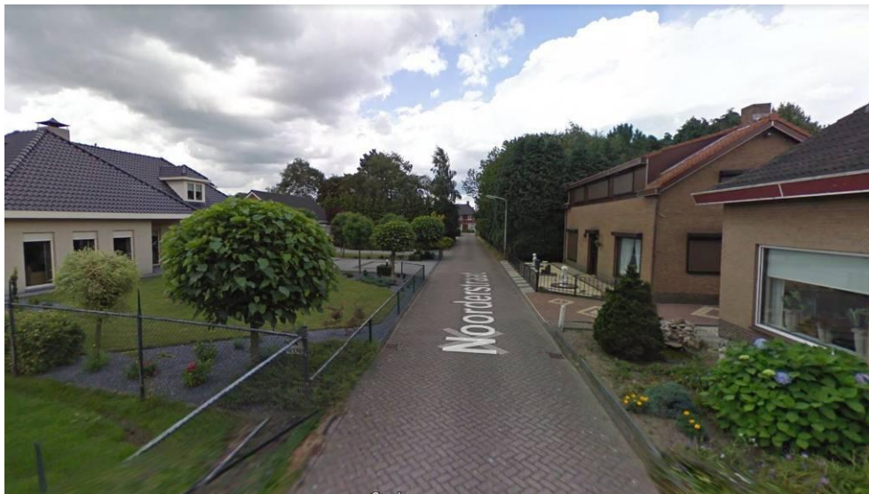
Figuur 7 - Het insteekweggetje, gezien richting Noorderstraat. Aan weerszijden vrijstaande woningen van één bouwlaag met kap (bron: Google Streetview, augustus 2010).
