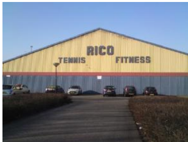
Foto 1. Vooraanzicht Rico Tennis- en Fitness-sportcomplex, welke deels deel uit maakt van de onderzoekslocatie.
