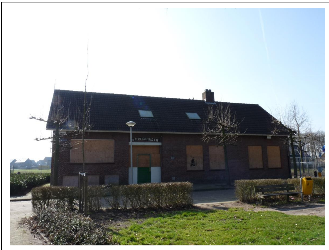
Foto 7. De voorzijde van de te slopen bebouwing "De Vissnberg".
