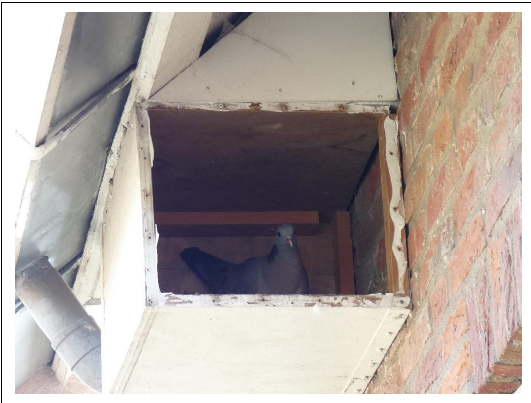
Foto 10. Nestlocatie van holenduif aan de te slopen bebouwing.
