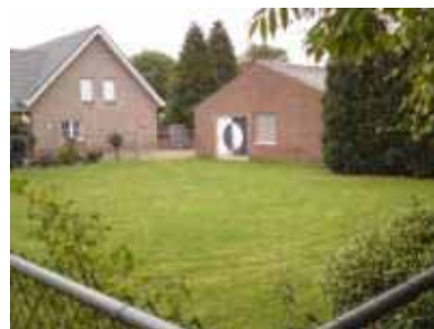
Het achterterrein van perceel D 7501, gazon, waarop de werkruimte is gepland. Op de foto is de achterzijde van de te slopen woon-/werkruimte (Noorderstraat 85 a ) zichtbaar.
