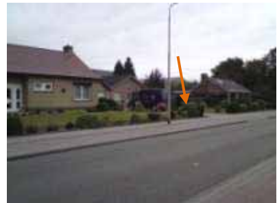
Bouwlocatie vóór de te slopen woon-/werkruimte en gelegen tussen de woningen Noorderstraat 85 en 87.
