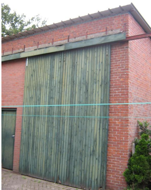
Schuur bij woning Sint Antoniusstraat 38
