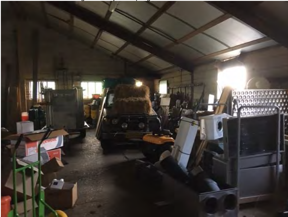
• Afbeelding 5: binnenzijde te slopen gebouw
