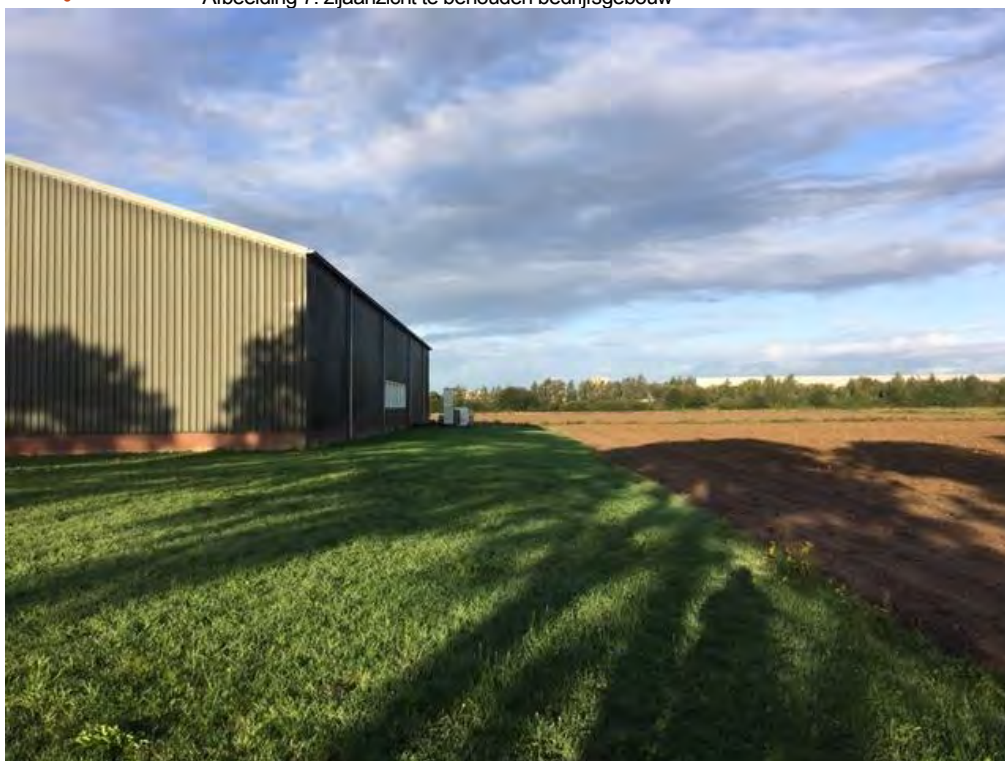
• Afbeelding 7: zij aanzicht te behouden bedrijfsgebouw
