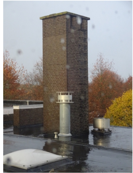
schoorsteen met toegankelijke binnenruimte
