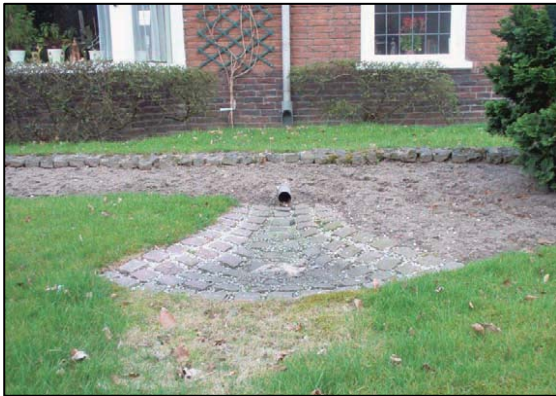
Figuur 24. Voorbeeld van een infiltratieveld.
