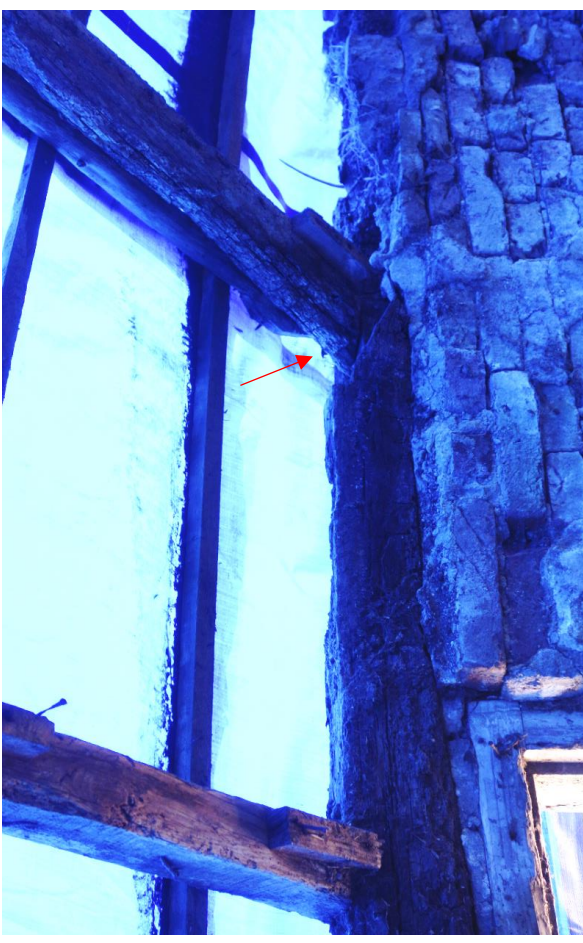
Detail van de aansluiting van de oorspronkelijke sporen ter hoogte van de muurplaat middels een ijzeren nagel (rode pijl).
