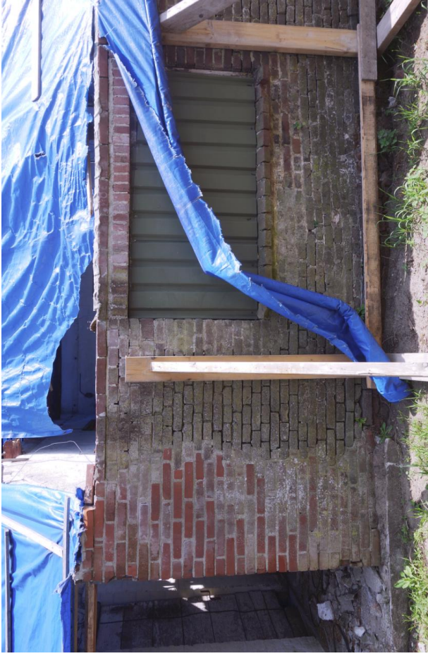
De overgang van het oudere muurwerk rechts, met het jongere muurwerk links in de westgevel.
