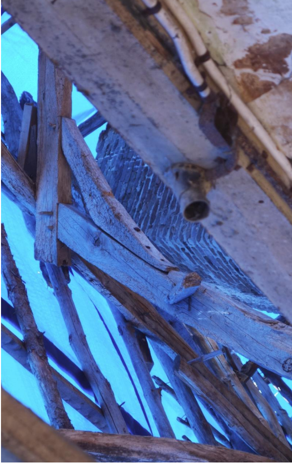
Zicht op het westelijke deel van het dekalkjuk boven het woongedeelte.
