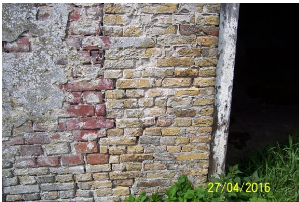
Rechts nieuw metselwerk ter plaatse van verwijdering kelder/opkamer
