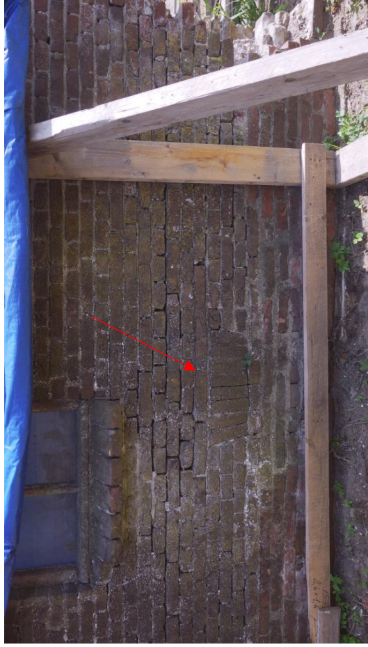
De overgang van het oudere muurwerk rechts, met het jongere muurwerk links in de westgevel.
