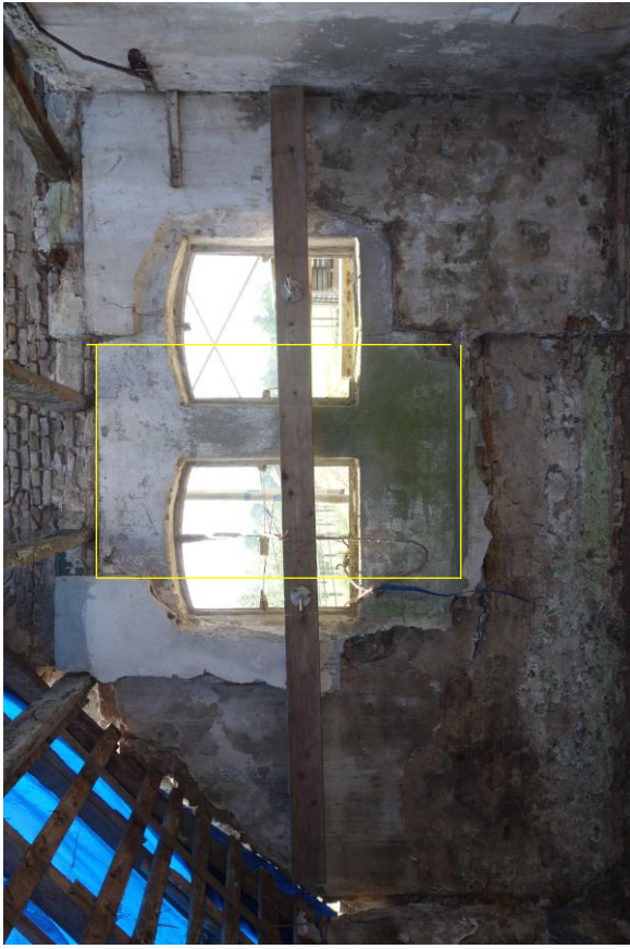
Zicht op de zuidgevel (voorgevel) vanuit de oostelijke hoekkamer. De gele lijn markeert de omtrek van het oorspronkelijke venster.
