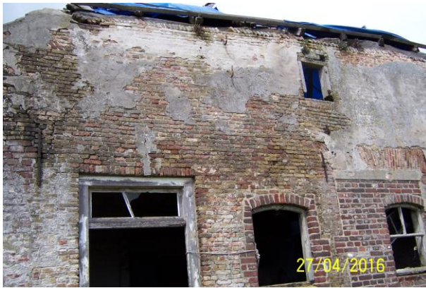
Detail voorgevel met rechts de plaats van het voormalige woonhuisvenster.
