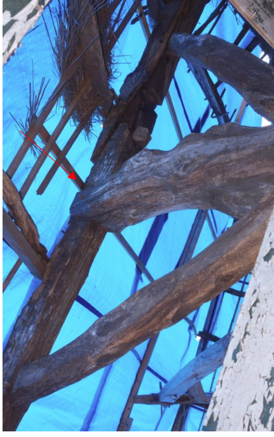
Zicht op de twee noordelijke ankerbalkgebinten in het bedrijfs gedeelte.
