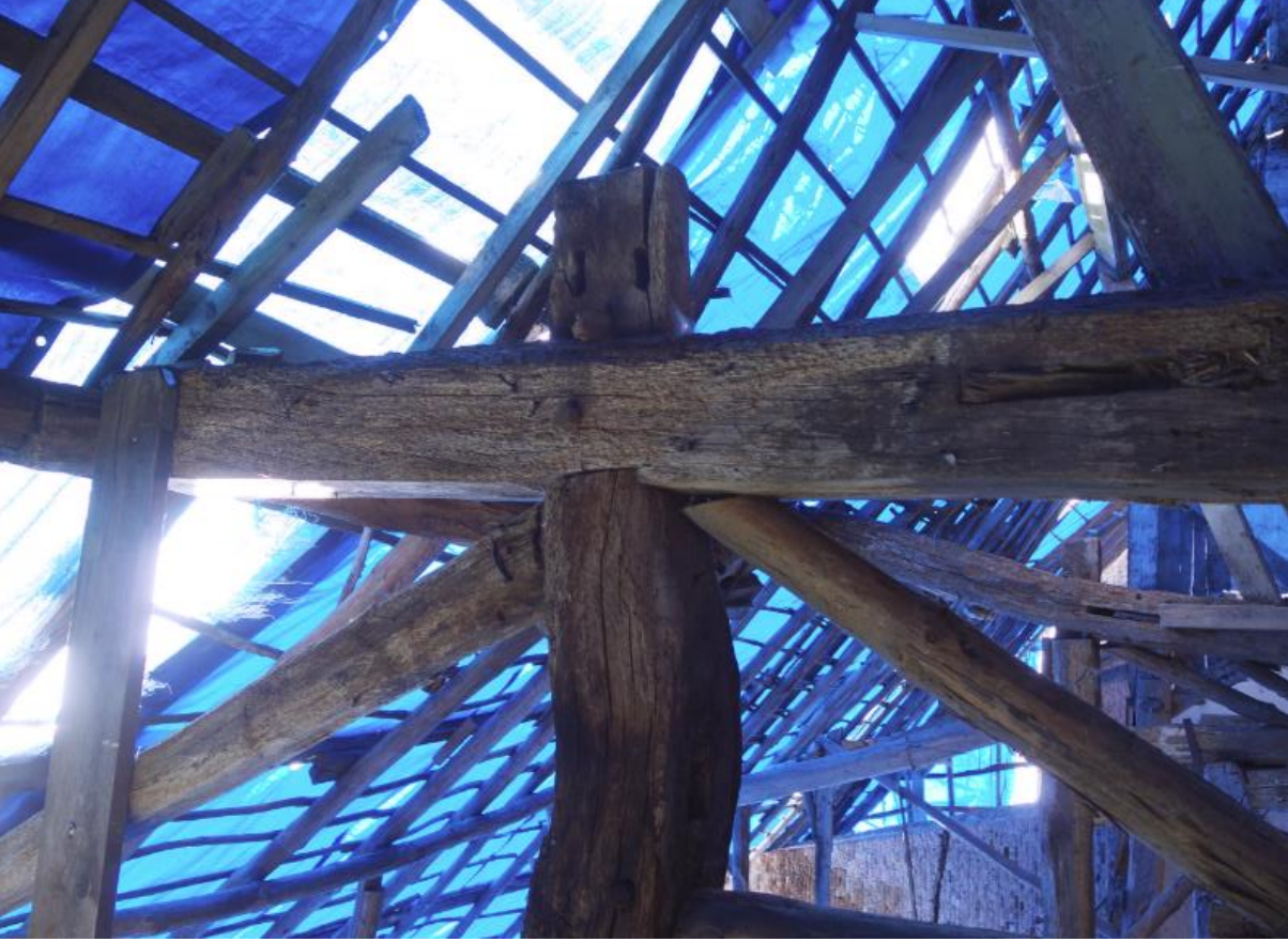
Detail van de westelijke gebintstijl met ankerbalk van het derde gebint, gezien vanaf het zuiden.
