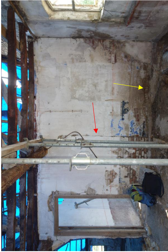
Zicht op de wand aan de oostzijde van de herd. De rode pijl wijst naar de verticale bouwnaad, de gele pijl naar de segmentboog onderin de muur.
