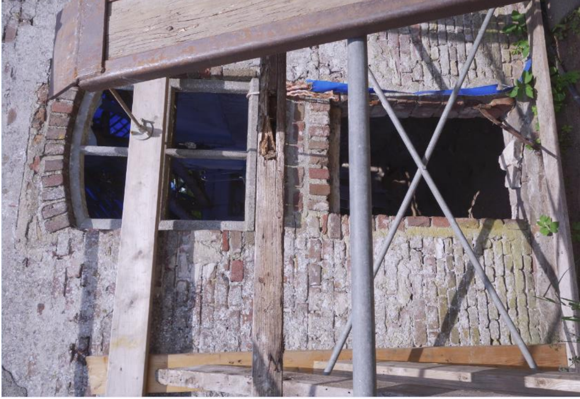
Detail van de voormalige keldertoegang en een betonnen 4-ruits raam in de zuidgevel uit de periode van na 1961.
