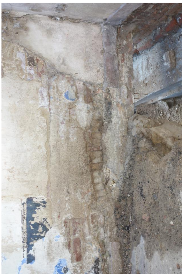
Een segmentboogje onderin de scheidingswand tussen de herd en de oostelijke kamer.
