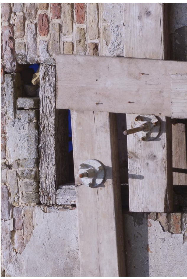
Detail van het oorspronkelijke eikenhouten zoldervenster in het bovendeel van de zuidgevel.
