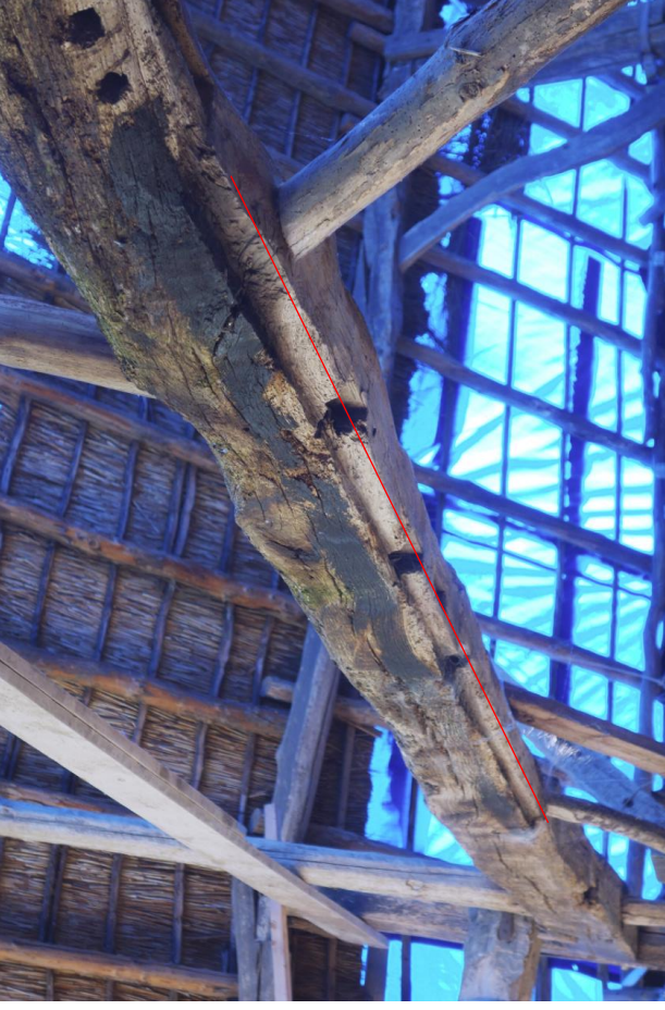
Detail van de ankerbalk van het meest noordelijke gebint, dat voorheen een strijkgebint was. Richting de straat is tussen de beide korseels nog een oude sponning zichtbaar, die behoort tot de positie van de eerste deeldeuren.
