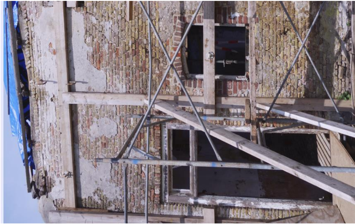
De doorgang in de zuidgevel behoort tot de oorspronkelijke opzet van de gevel maar bevat thans een veel jonger, vlak kozijn.
