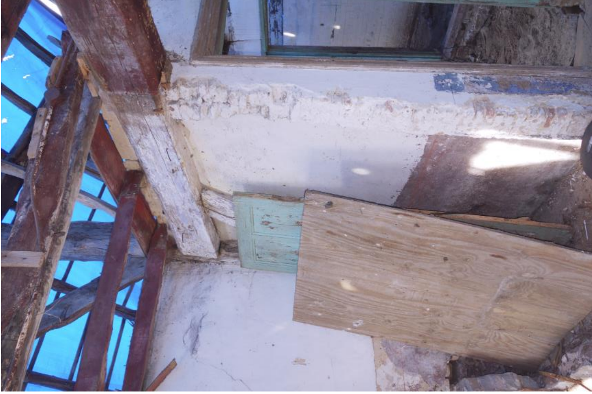
Detail van de samengestelde balklaag boven de centrale voorkamer in het woongedeelte, ter hoogte van het eerste gebint, waarbij de ankerbalk als moerbalk is gebruikt.
