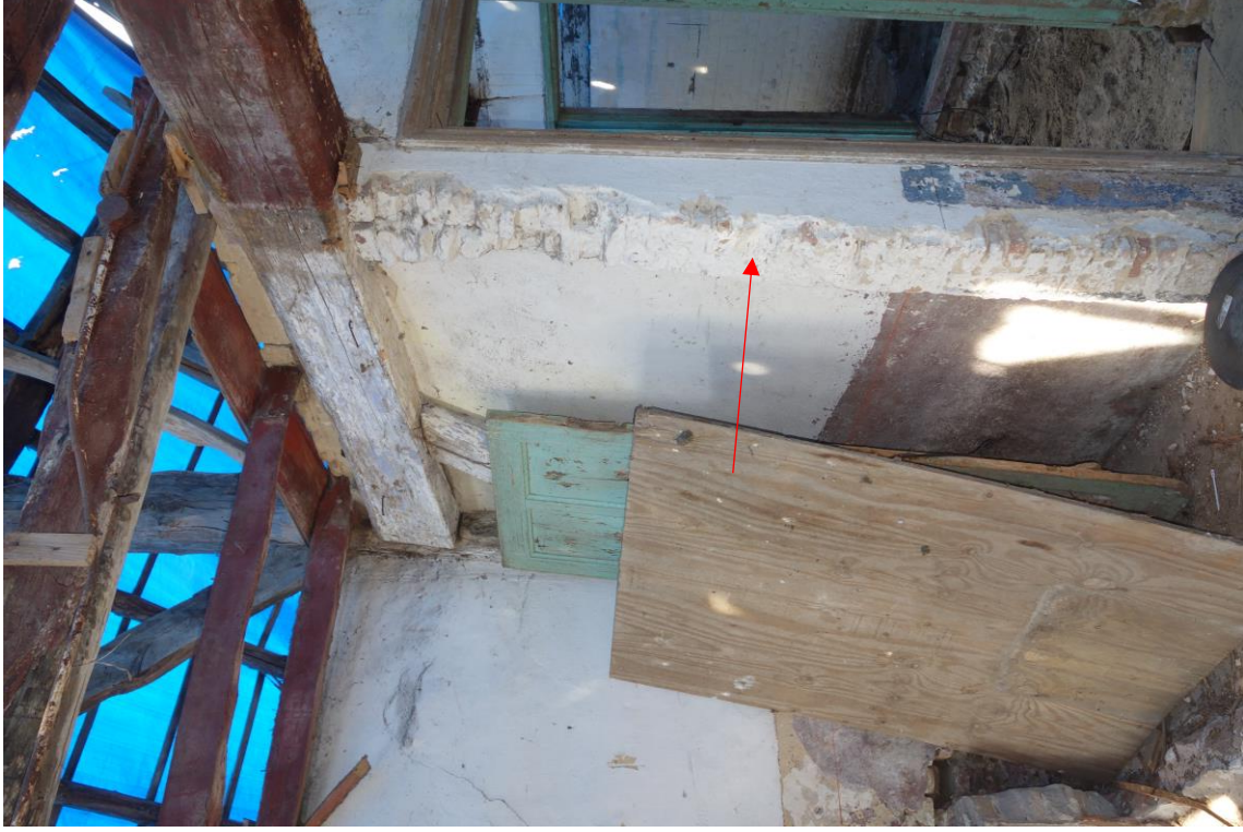
Zicht vanuit de herd richting de voormalige, achter de muur aan de westzijde gelegen opkamer. De rode pijl wijst naar de ten behoeve van de aanleg van een stal met voergoot in 1961 weggebroken gangmuur, die ook in dit eerste deel een bedstede aan de zijde van de herd afsloot.
