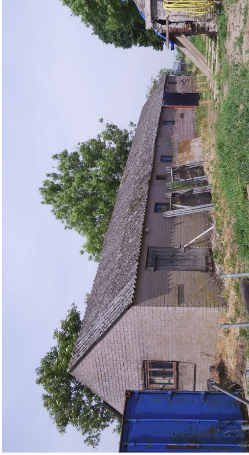
Zicht op de oost en zuidgevel van de zeugstal uit 1976. Het voorste deel betreft een latere uitbreiding in betonstenen.
