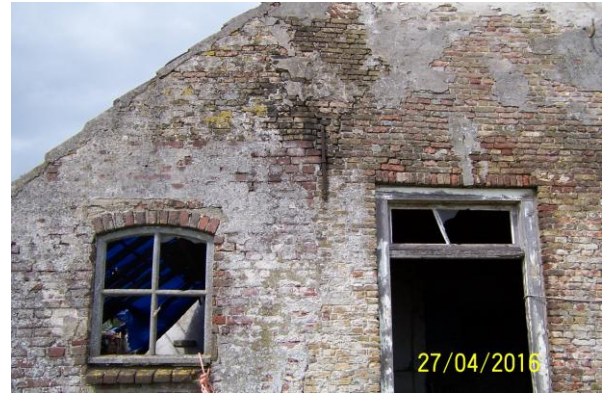
Stalraam ter plaatse van het opkamer- raam.
