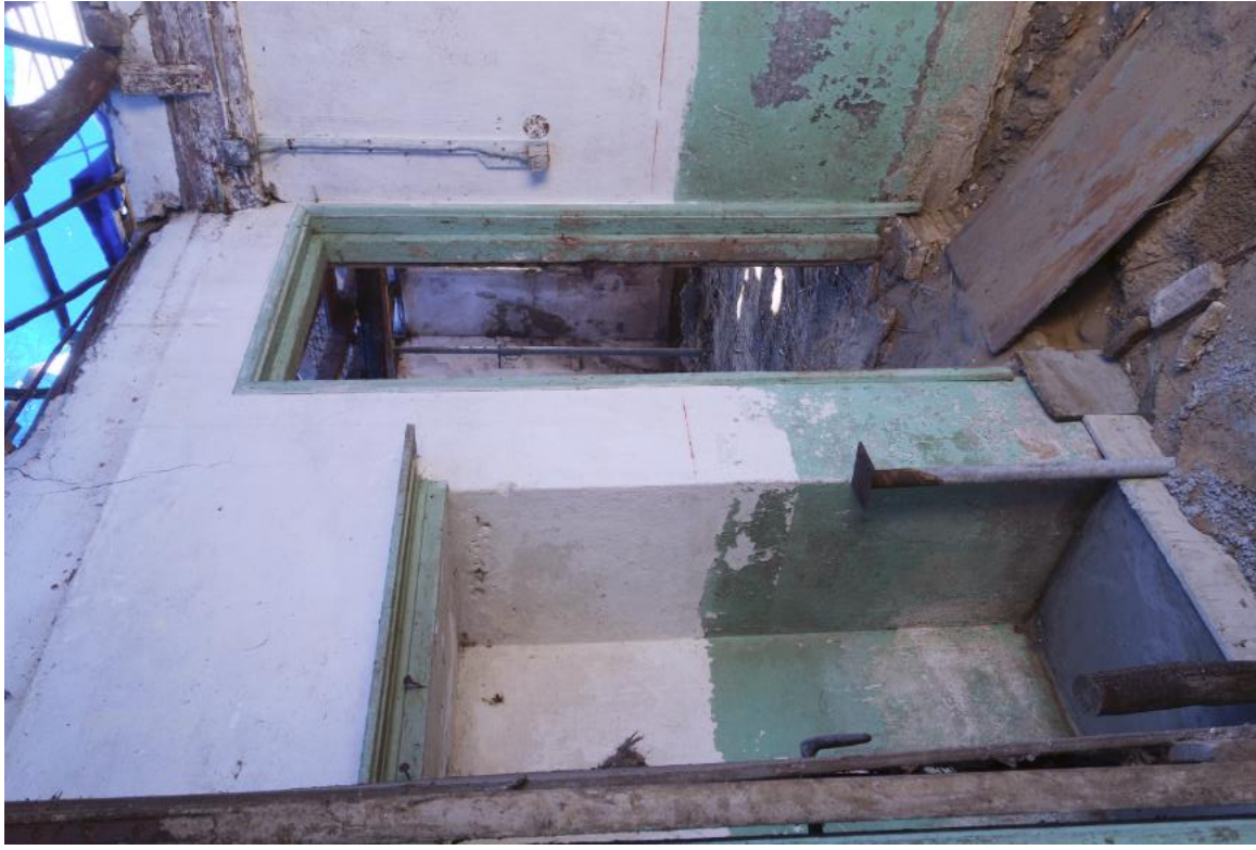
Zicht op de later ingebouwde kast aan de westelijke zijde van de haard. De doorgang leidt naar de herd. Delen van het muurwerk rond het kozijn en rechts onder de gebintbalk zijn van later datum.
