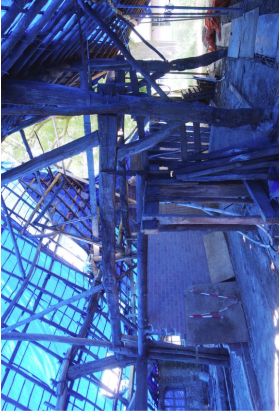
Zicht op de twee noordelijke ankerbalkgebinten in het bedrijfs gedeelte.
