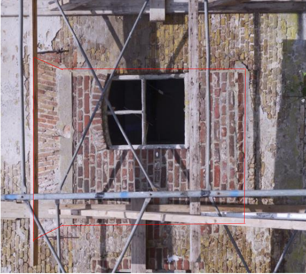
Detail van het oorspronkelijke dichtgezette venster centraal in de zuidgevel.
