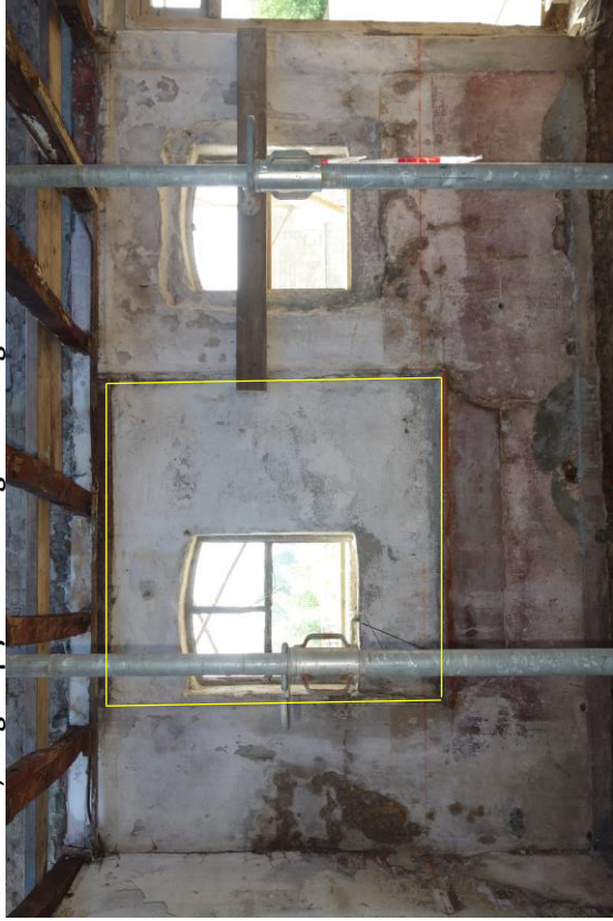
Zicht op de wand aan de oostzijde van de herd. De rode pijl wijst naar de verticale bouwnaad, de gele pijl naar de segmentboog onderin de muur.
