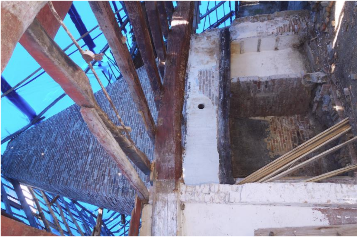
Zicht op de grote schouw met rookkanaal die aan de achterzijde van de centrale voorkamer is gelegen en bij de vroegste kern van de boerderij hoort.
