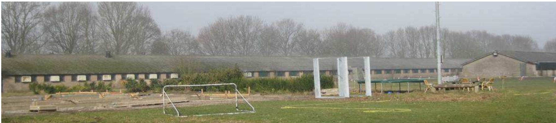
Figuur 2: Foto van de bebouwing ter plaatse en de bouw van de nieuwe paardenstal op de voorgrond.
