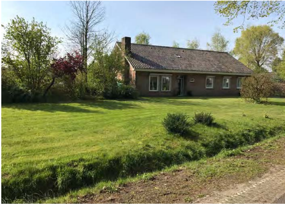
De woning aan de Heistraat
