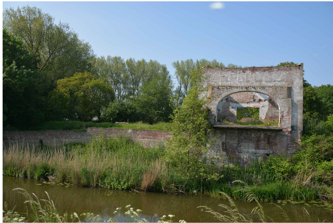
Aanzicht keermuur zuidgevel
