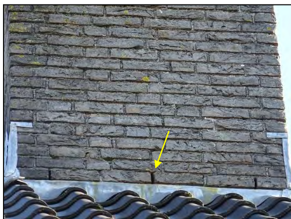
Figuur 19. Open stootvoegen in schoorsteen geschikt voor vleermuizen.
