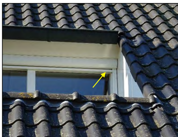
Figuur 22. Ruimte in rolluikkasten geschikt voor vleermuizen.
