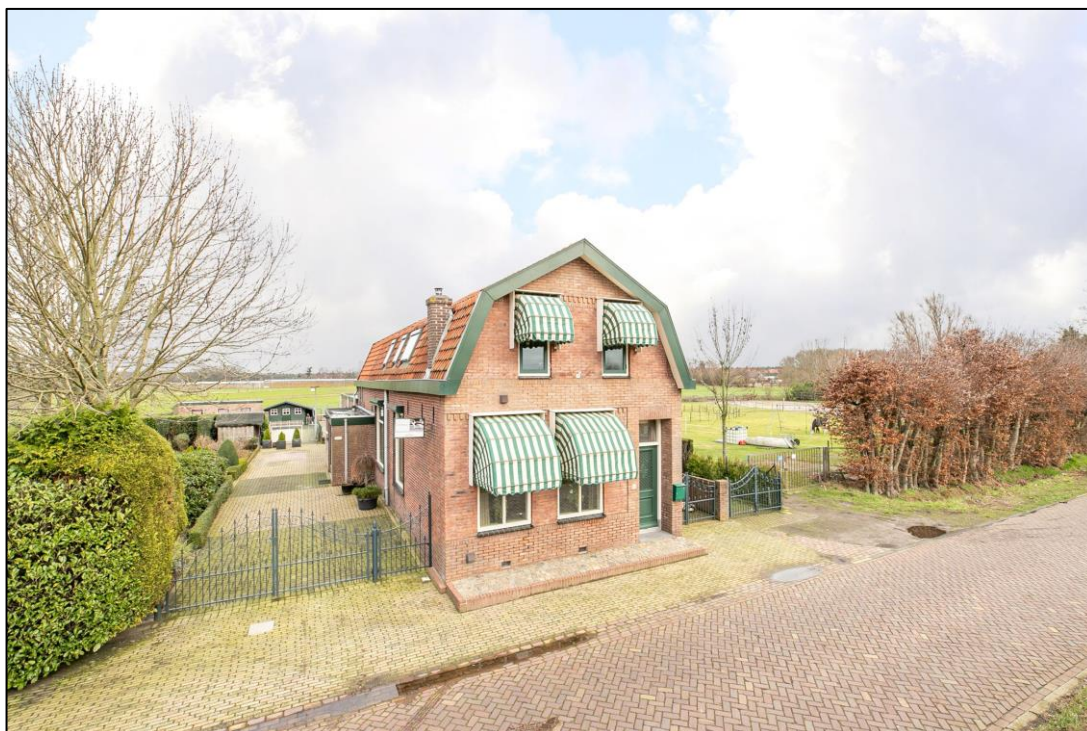
Figuur 4 Bestaande woning
