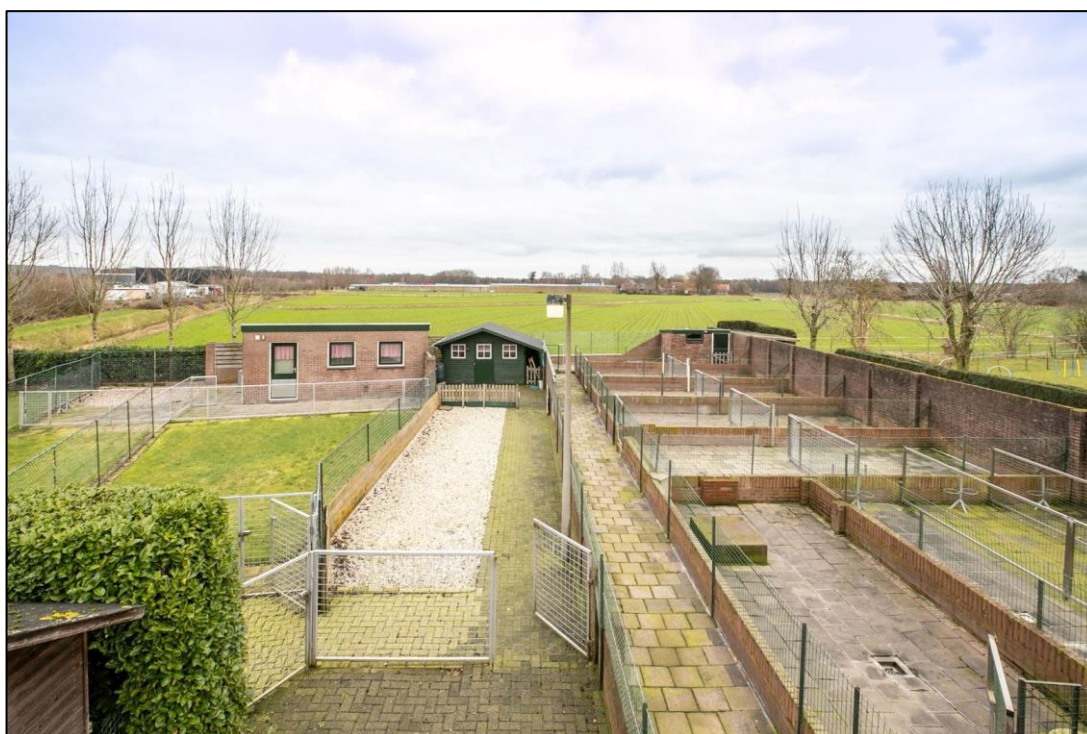
Figuur 5 Buitenverblijven voormalige hondenkennel
