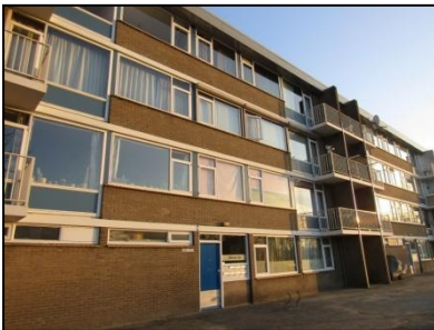
Figuur 3. Een van de drie te slopen appartementgebouwen.
