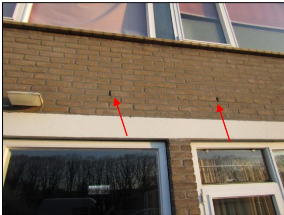
Figuur 14. Geschikte openingen kunnen toegang verlenen tot spouwmuur.
