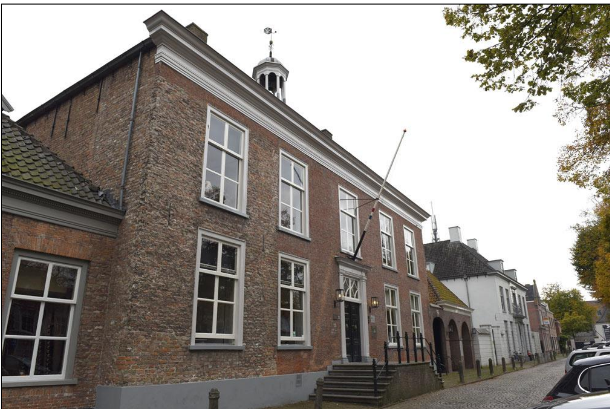
Figuur 5. Het voormalige gemeentehuis aan de Heuvel in Oosterhout, huidige situatie. Nu is hier het Vrijheidshuis gevestigd. Hier viel op 30 oktober 1944 een granaat waarbij schade aan de gevel ontstond. Foto: www.tracesofwar.nl .
