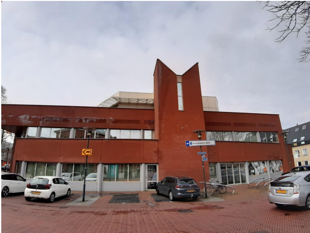
Foto 2: Te slopen kantoorgebouw.
