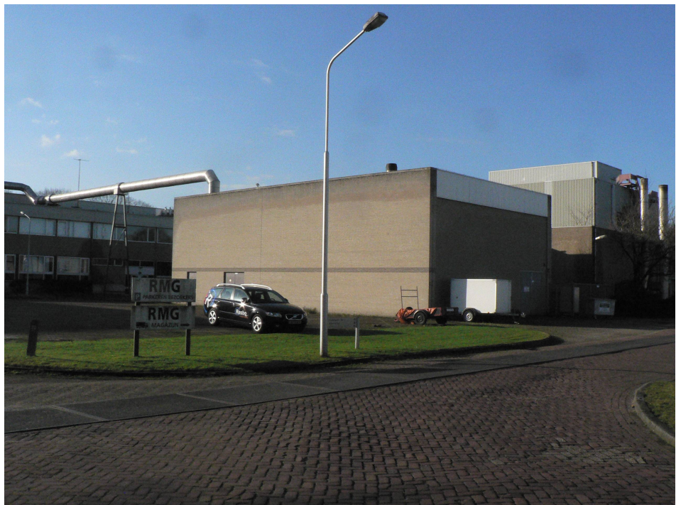
Figuur 3. Vooraanzicht van het af te breken MPO-gebouw, noordelijke deel.
