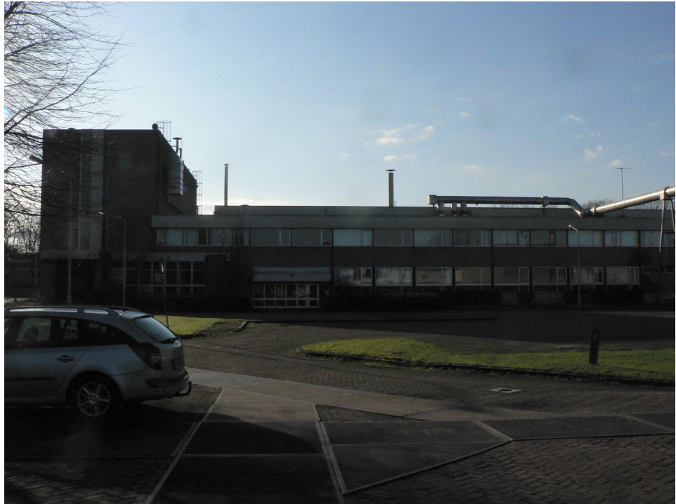
Figuur 2. Vooraanzicht van het af te breken MPO-gebouw, zuidelijke deel.
