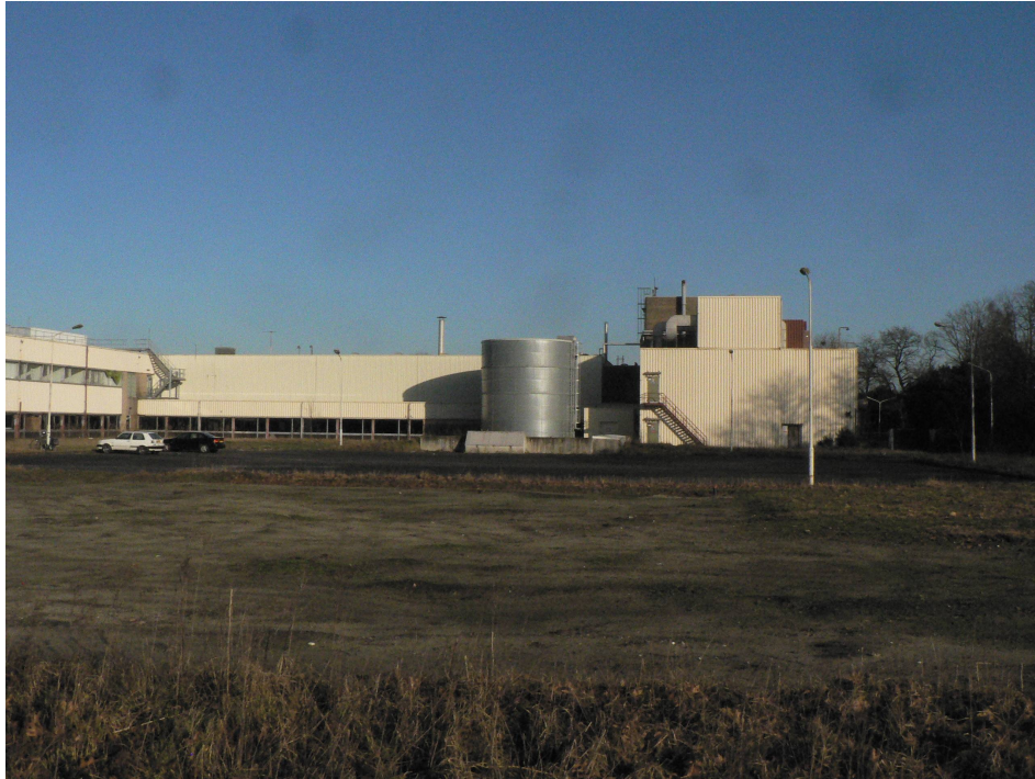
Figuur 4. Achteraanzicht van het af te breken MPO-gebouw.
