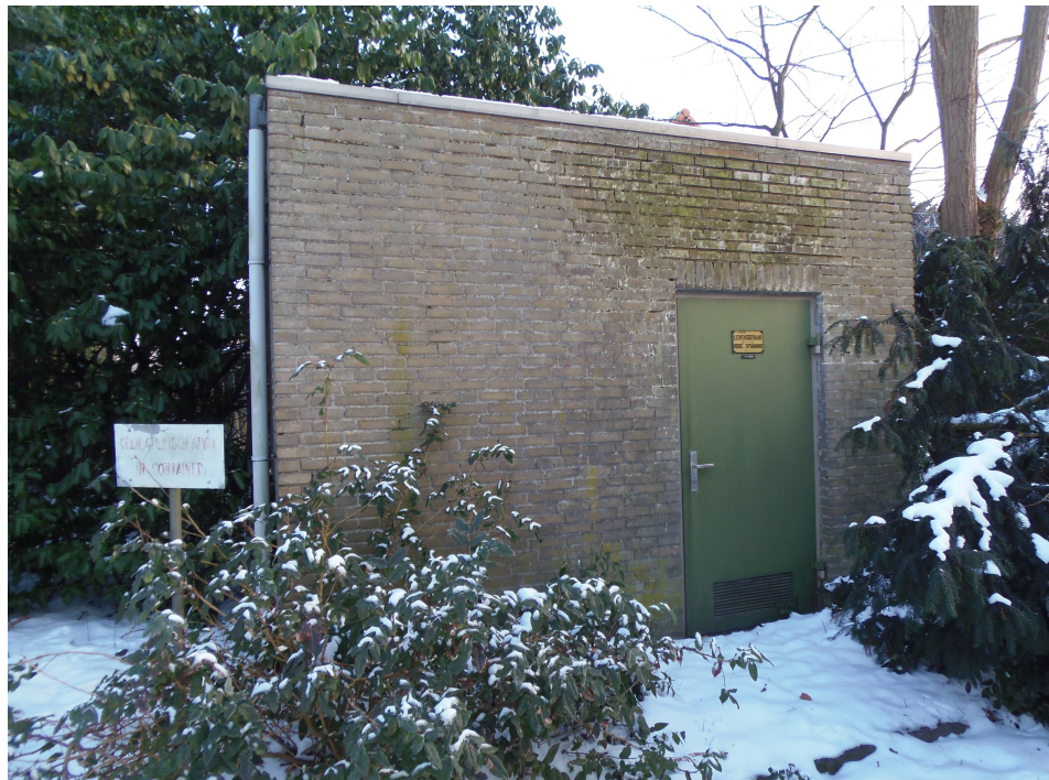
Figuur 5. Electriciteitshuisje binnen het plangebied is toegankelijk voor vleermuizen en mogelijk in gebruik als verblijfplaats.
