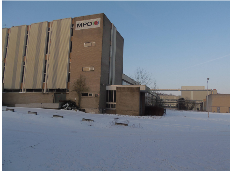
Figuur 4. Stenen muren van het bedrijfspand met spouwmuren zijn potentieel in gebruik als verblijfplaats van vleermuizen.
