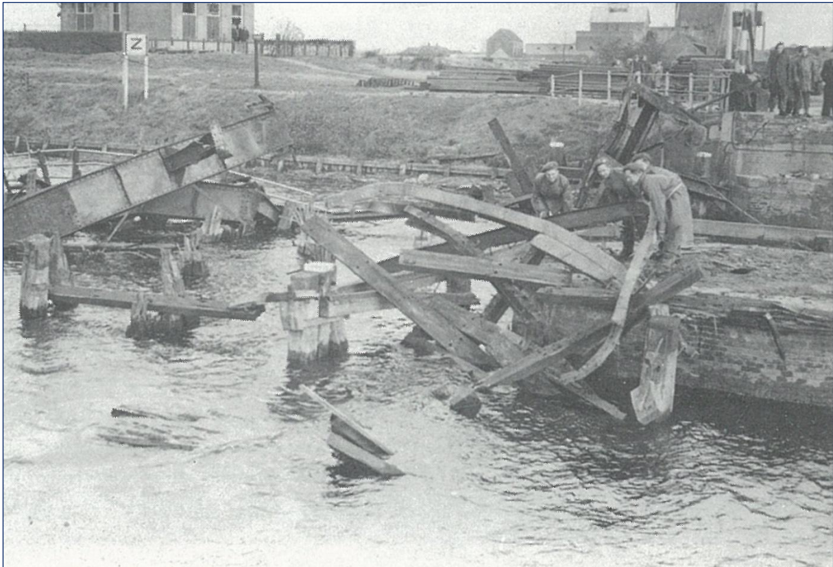
Figuur 3: De opgeblazen brug in de Bredaseweg over het Wilhelminakanaal (bron: Alphen, Oosterhout 1944-1945 , 75).
