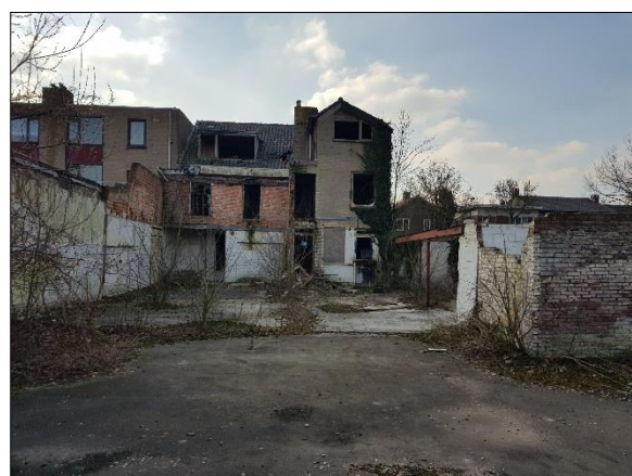
Figuur 4. Achterzijde woning
