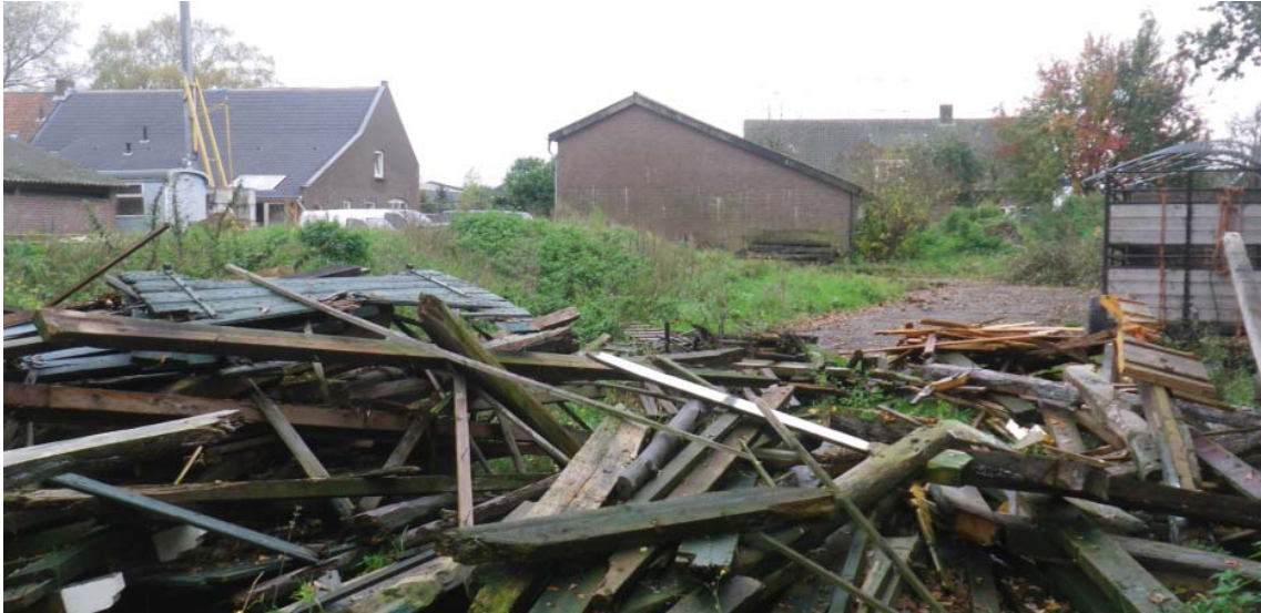
Meest zuidelijke deel van de zone met bebouwd gebied nabij de Heuvelstraat, ruigte en deels verhard, ZO-richting.
