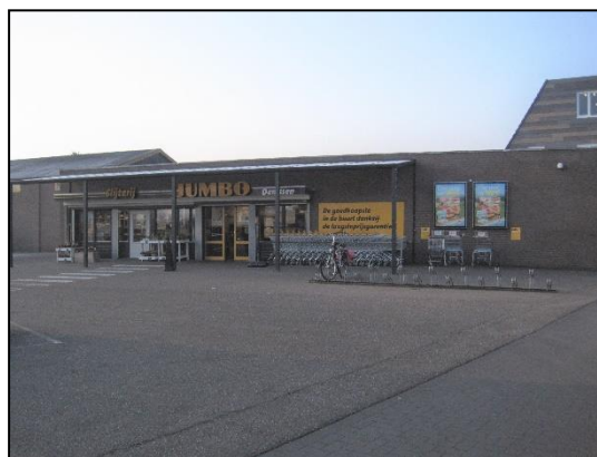
Noordzijde supermarkt met plat dak
