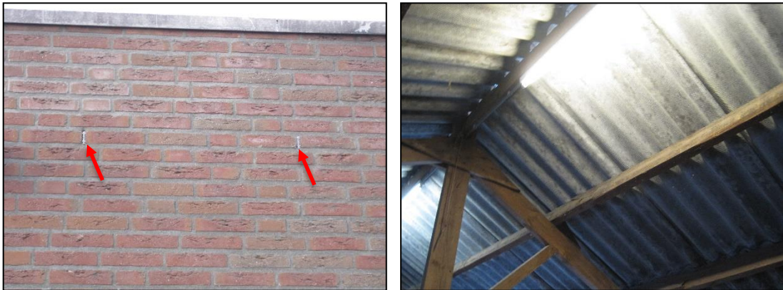
Figuur 6. Open stootvoegen afgesloten met roosters (links) en dak schuur met enkele laag golfplaten (rechts).
