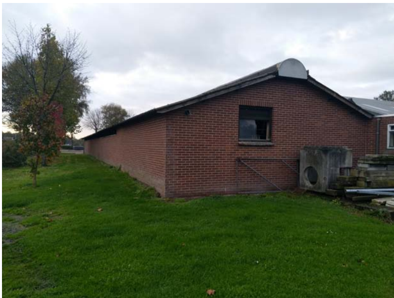
Achterkant voormalige stal/ sloop
