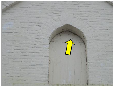
Figuur 15. Ruimte tussen luik en muur.
