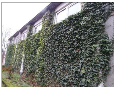
Figuur 6. De noordwestzijde van de onderzoekslocatie.
