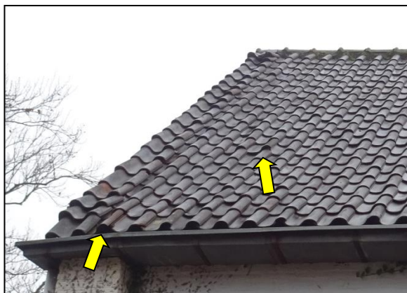
Figuur 9. Ruimtes onder de dakpannen.
