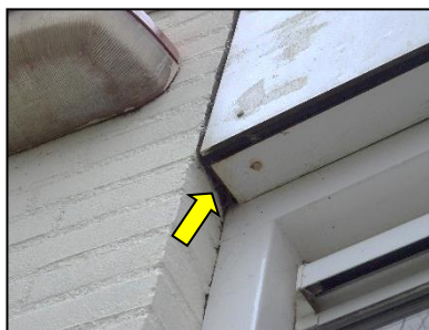
Figuur 11. Ruimte achter de betimmering.
