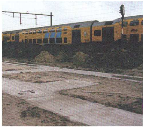
Alle verzwaarde funderingssloven zijn gekoppeld tot een geheel.
