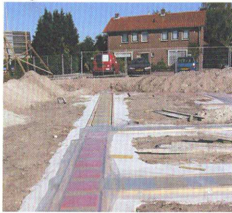
De trillingisolerende matten op de sloof (rood). Tussen de matten het steenwol.
