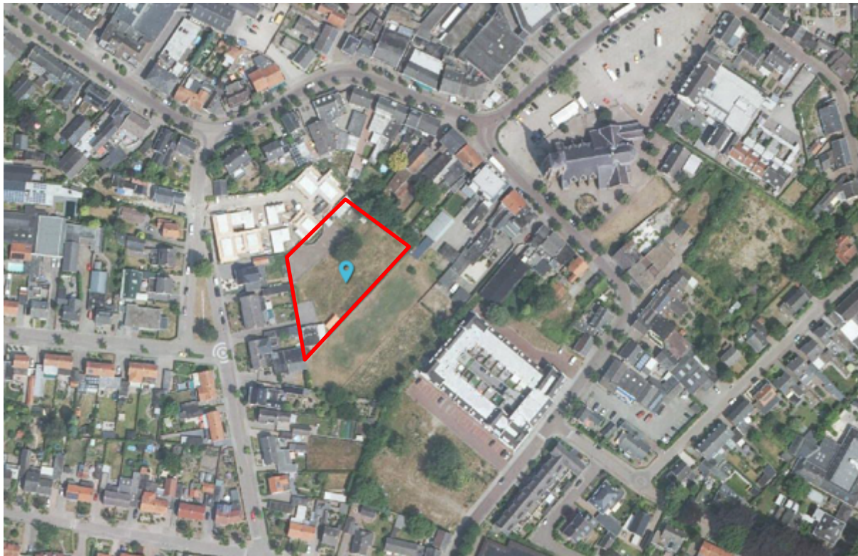
Luchtfoto Moergestel met in rood de projectlocatie, bron: ruimtelijkeplannen.nl
