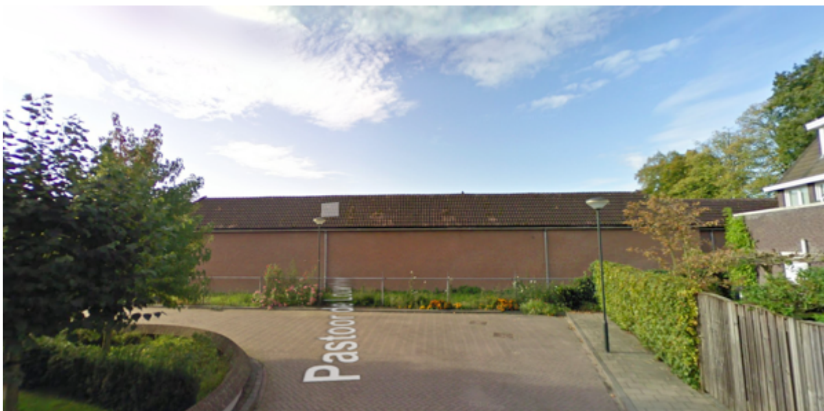
Foto bestaand pand aan de noordzijde gezien vanaf Pastoor de Louwstraat; fragment: google Street View (september 2010)
