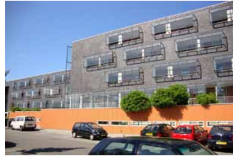
nieuwbouw 't Schop
