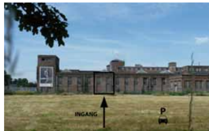
voormalige ververij (gebouw 2)
