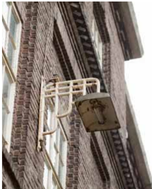
verlichting aan gebouw 28 en 32
