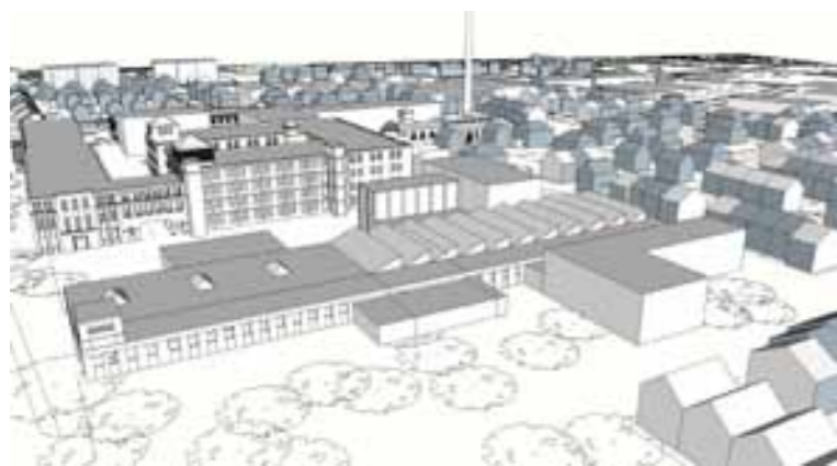
voormalige ververij (2), schaverij (3) en looierij (4) tussen de nieuwbouw in het stedenbouwkundig plan.
