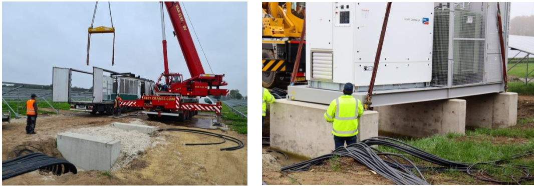
FIGUUR 18: BETONFUNDERING OP ZONNEPARK SOMEREN (LINKS) EN OP ZONNEPARK LOCHEM (RECHTS).
