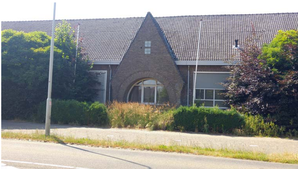
Voorzijde van het schoolgebouw aan de Andreasstraat
