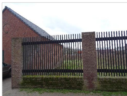
Foto 7: Stenen muur/schutting langs oostzijde plangebied/grens Heistraat. (met trafo zuidoostzijde buiten plangebied).
