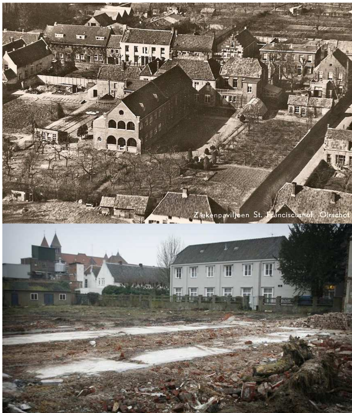
Figuur 4. De zuidelijke vleugel van het hof van Solms in 1919 (boven) en na de sloop in 2010 (onder). Bron: https://erfgoedstem.nl/oirschot-vleugel-hof-van-solms-was-monument en https://www.ed.nl/overig/hof-van-solms-wijze-les
