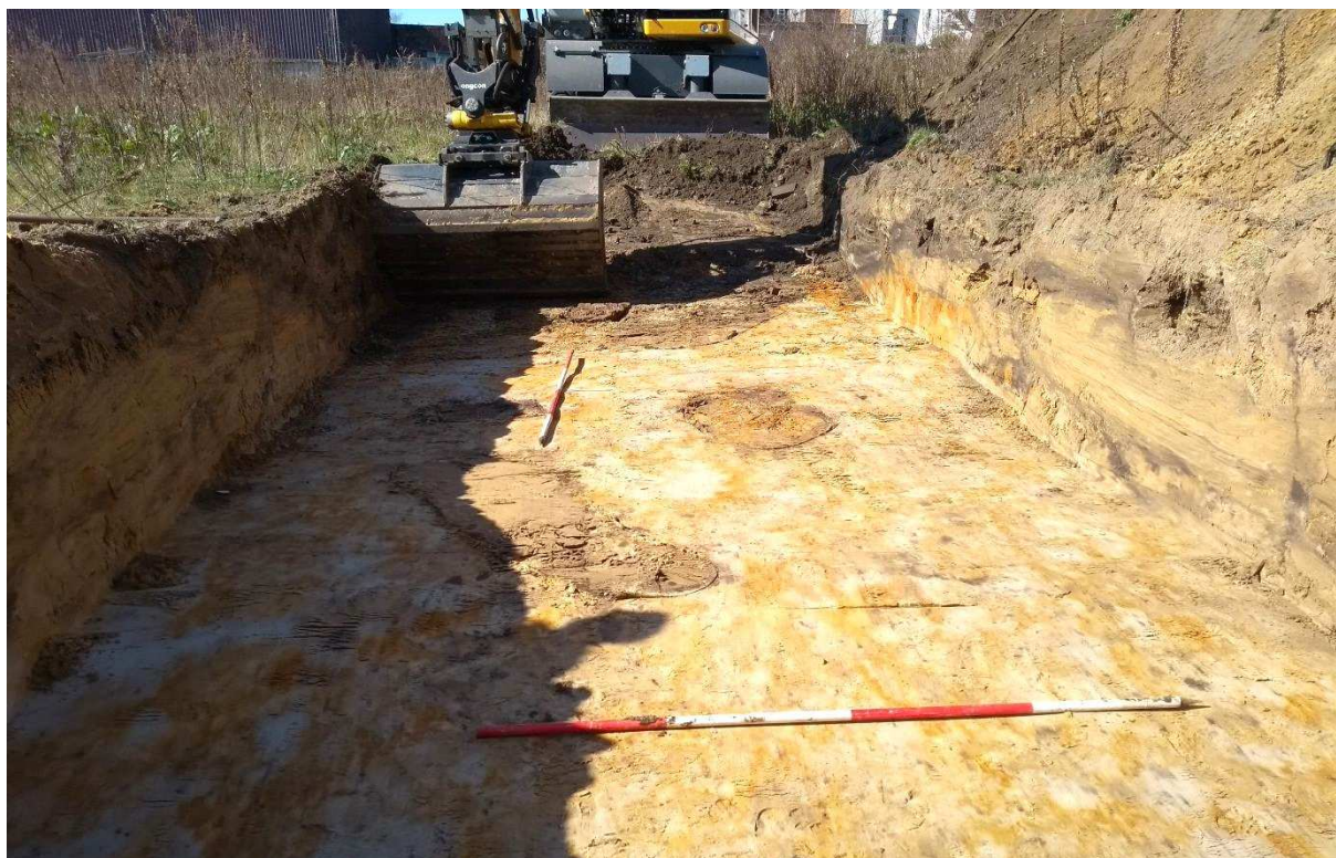
Figuur 7. Aanleg van het vlak in WP3 met behulp van een graafmachine met een gladde bak.
