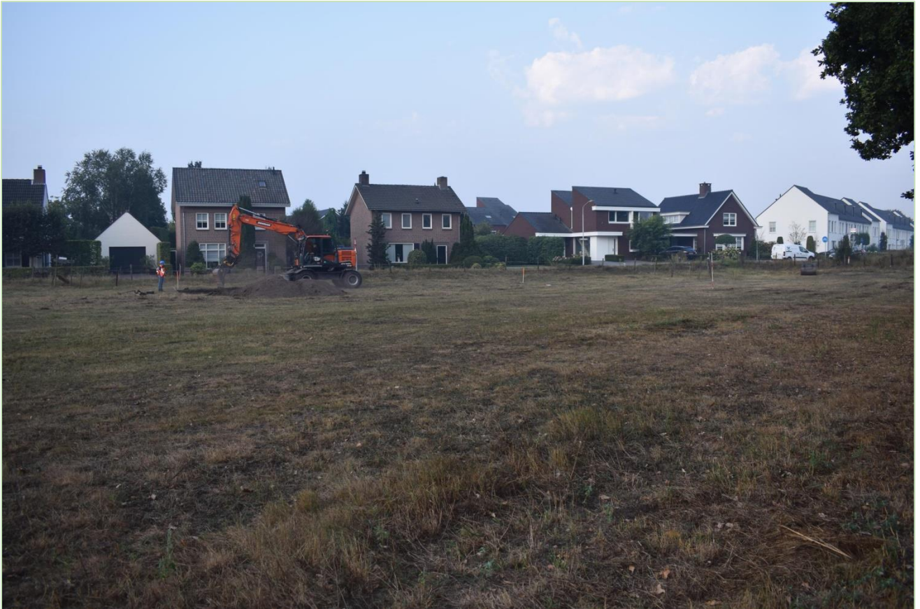
Figuur 3: Zicht op het plangebied, kijkende in zuidwestelijke richting, bij aanvang van het veldwerk.
