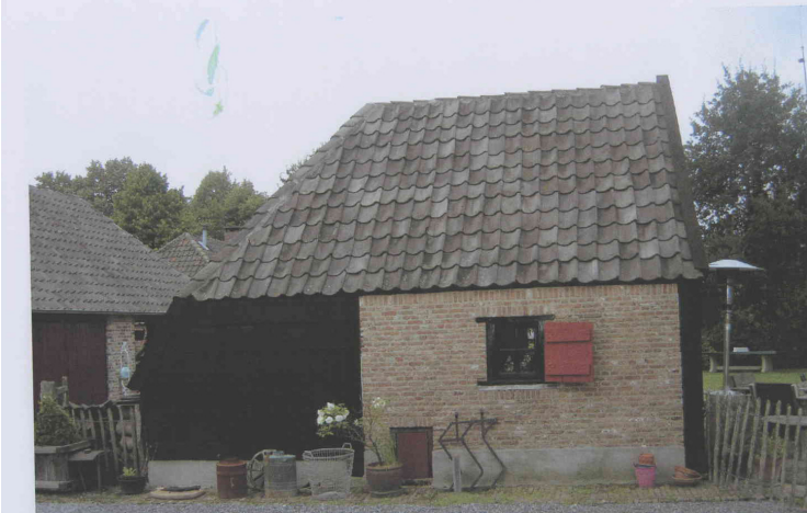
Huidig bijgebouw in welke bouwstijl de nieuwe berging wordt gerealiseerd
