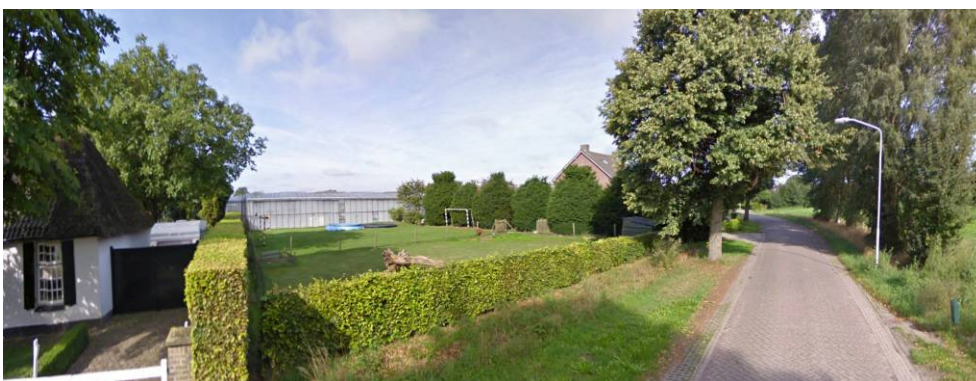
Bestaande situatie aan de Putstraat (Google Streetview, augustus 2010)
