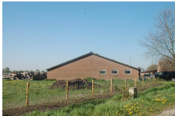
Afbeelding: rundveeststal achterzijde
