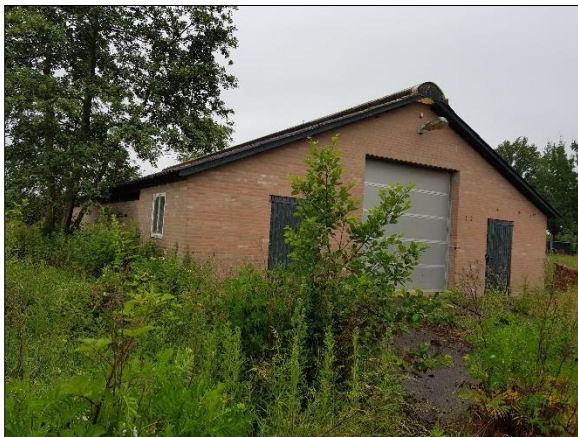
Figuur 6. Oostzijde loods
