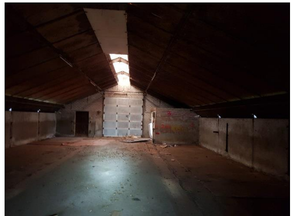
Figuur 7. Binnenzijde loods
