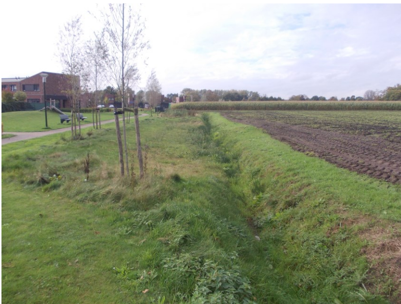
Begrenzing van de Bolle Akker met de Esrand. De steilrand is hier opgenomen in een sloot met aansluitende wadi's.
