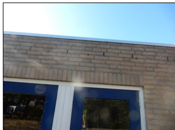
Figuur 10. Open stootvoegen die toegang kunnen verlenen tot de spouwmuur.
