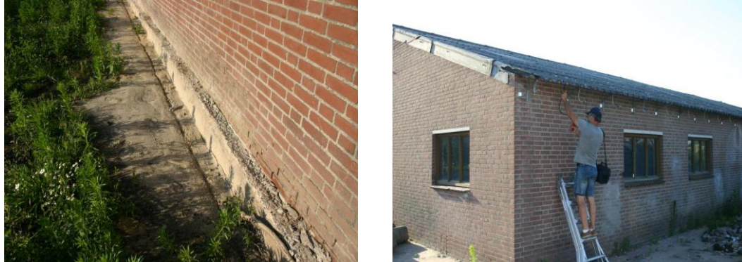
Figuur 4.10. (L) Sporenbed bij Vorsterdijk 12 en (R) inspectie gebouw met endoscoop.
