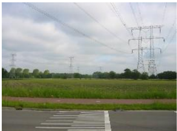
Hoogspanningmasten over Wolvendijk
