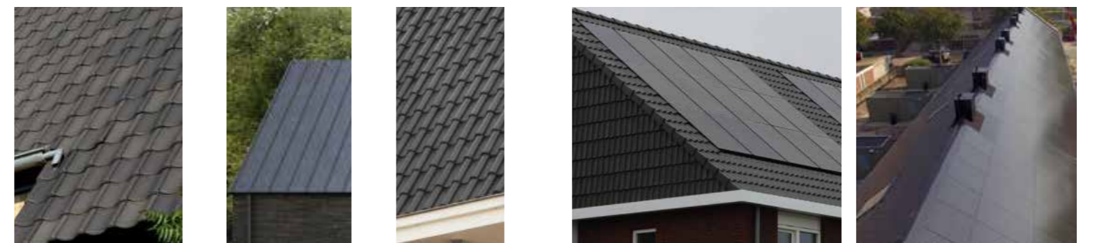
DAKBEDEKKING, HELLENDE DAKEN Materiaal keramisch | metaal (geen golfplaat) Kleur mat antraciet, (afstemmen met het zonnepaneel)
