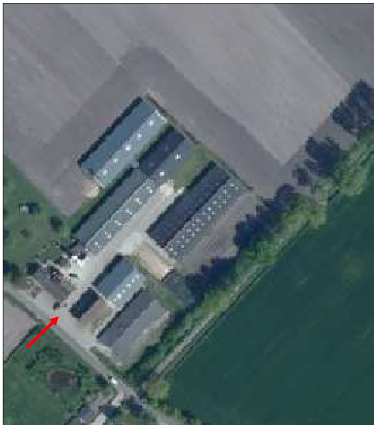
Figuur 22: Ontsluiting bedrijf aangegeven met rode pijl
