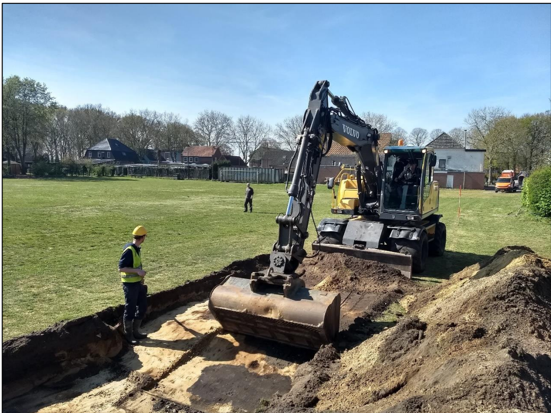
Figuur 2. Overzichtsfoto van werkput 2, vlak 1, gezien richting het zuidenwesten.
