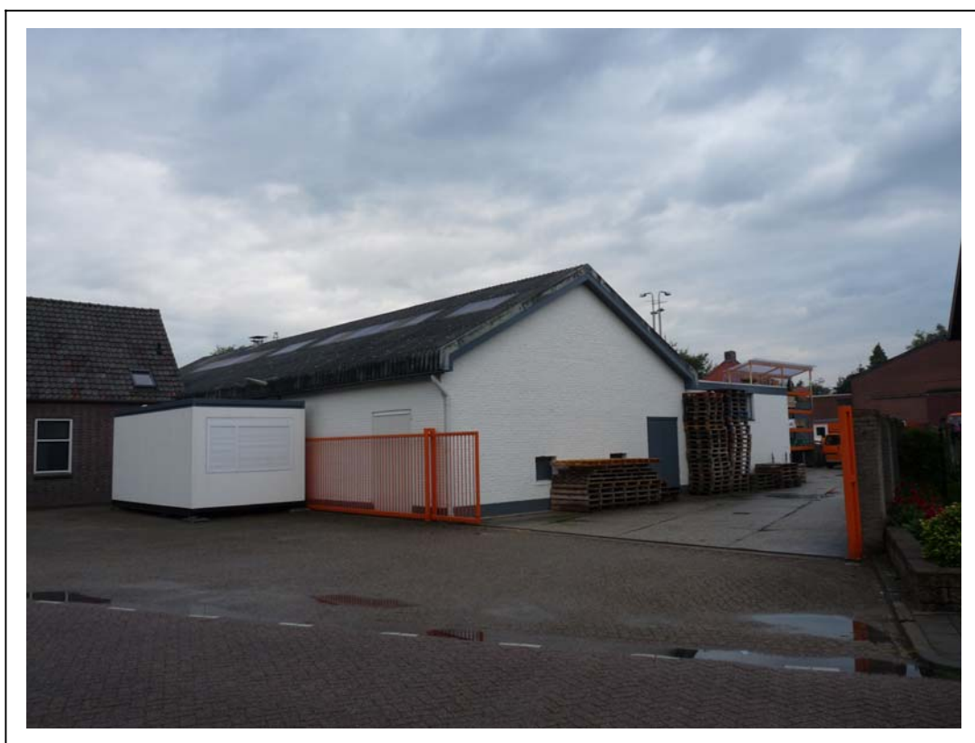
Foto 6. werkplaats op het achterterrein van de onderzoekslocatie
