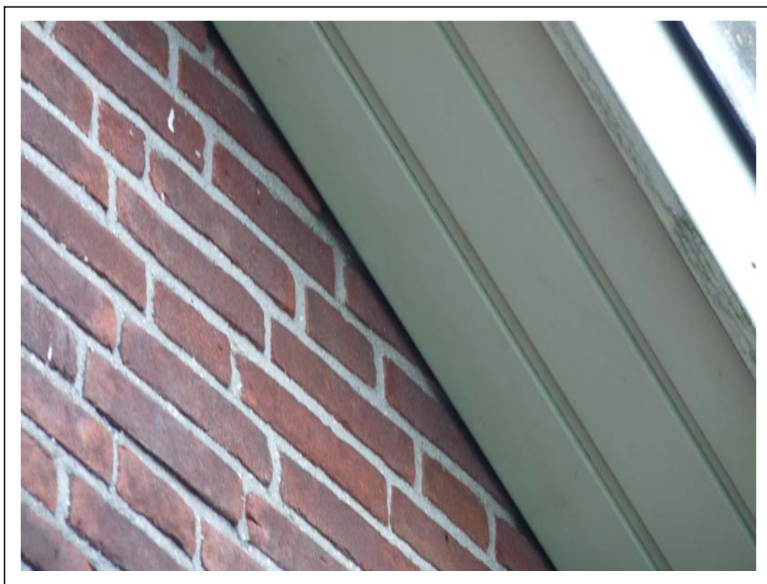
Foto 4. geschikte wegkruipmogelijkheid voor vleermuizen in kanttorpand
