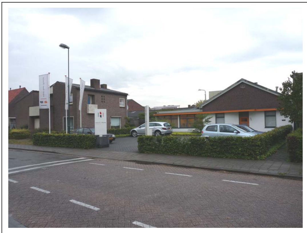
Foto 1. voorzijde onderzoekslocatie met links woonhuis nr. 8 en rechts kantoorpand
