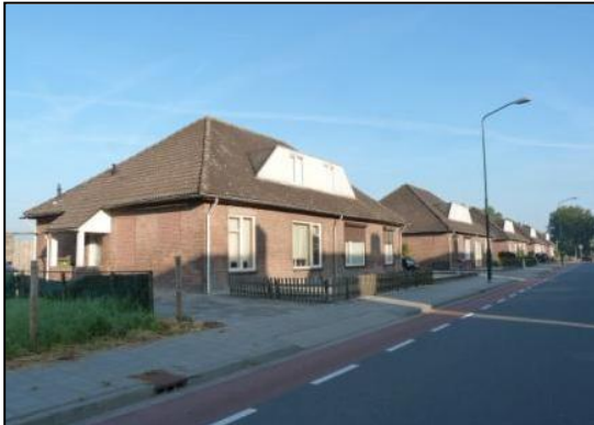
Aanzicht van de twee te amoveren woningen aan de Sweensstraat.
